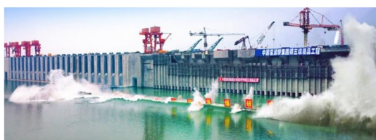
图3 三峡工程三期RCC围堰拆除爆破
