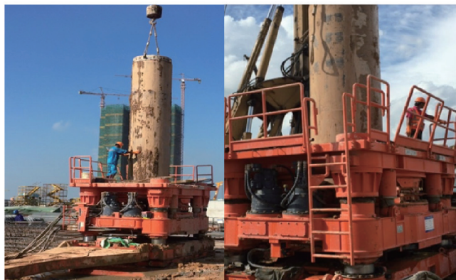
图5. 摇动式套管钻机施工。
