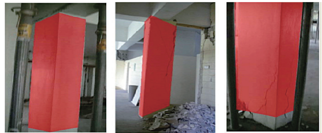
图9. 钢筋混凝土柱子的识别结果[153]。
