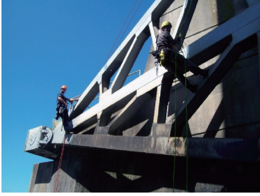
图1. 美国陆军工程兵团的检查员从闸门垂降，检查表面是否有损坏。
