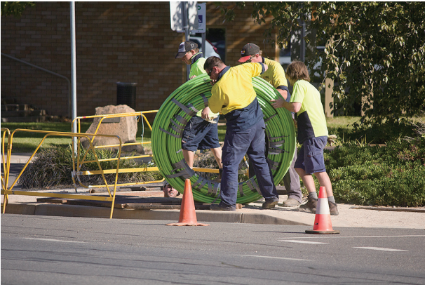
图1. 工人在澳大利亚新南威尔士州沃加沃加铺设新型光纤电缆。铺设这种光纤电缆的高昂成本促使人们开始研究如何扩大现有光纤所能承载的信息量。图片来源: Bidgee, Wikimedia Commons (CC BY-SA 3.0 Au)。
