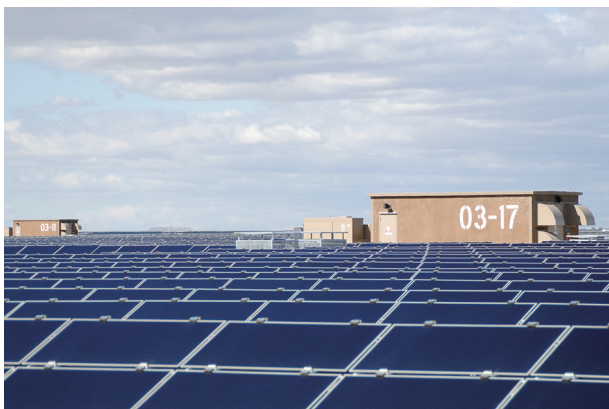
图1. 使用可再生能源发电的成本已经低于使用天然气发电的成本，如美国加利福尼亚州圣路易斯奥比斯波县巨大的黄玉光伏电站收集的太阳能。该设施占地25.6 km 2 ，通过运用900万片薄膜碲化镉电池板可以发电550 MW。资料来源：Sarah Swenty/USFWS（CC BY 2.0）。
