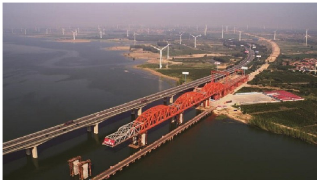
图12. 官厅水库特大桥同步顶推。
