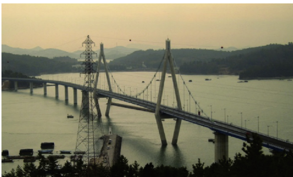
Fig. 1. The Sorok Bridge.
