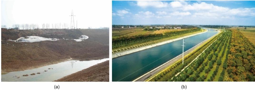
图5. (a) 膨胀土滑坡堵塞渠道; (b) 中线工程膨胀土渠道。
