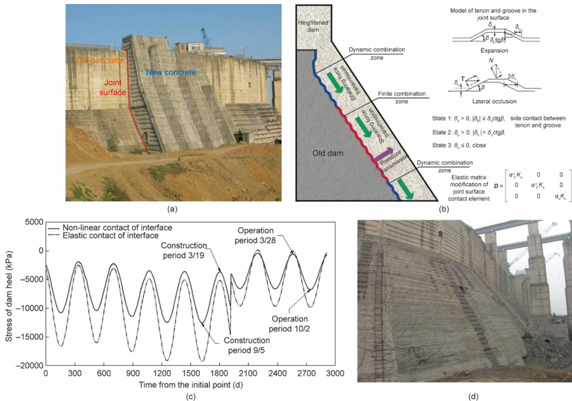
图4. (a) 大坝加高现场试验; (b) 后帮有限结合传力结构模型; (c) 考虑温度荷载的坝踵应力时程曲线; (d) 大坝加高结合面处理。 $\delta_n$ 为法向位移;  $\beta$ 为结合面夹角;  $D$ 为弹性刚度矩阵;  $\alpha_h^x, \alpha_h^y$ 分别为局部坐标系下x、y向的切向修正系数;  $\alpha_n$ 为局部坐标系下法向修正系数;  $K_s$ 为切向刚度;  $K_n$ 法向刚度;  $N$ 为法向力;  $T$ 为切向力。
