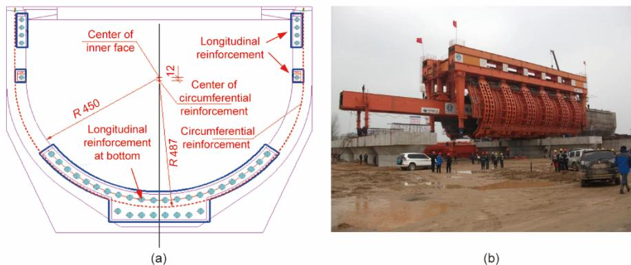
图10. (a) 湘河渡槽预应力筋布置图；(b) 超大U形渡槽造槽机机械化施工。R: 半径 (cm)。
