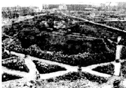
图 5 制作第一道支撑
