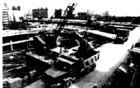
图 7 支撑上的停机平台
