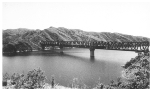
图 4 北京密云水库白河新钢种试验大桥
