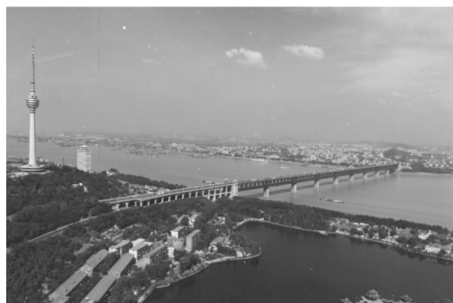
图 1 武汉长江公铁路大桥
