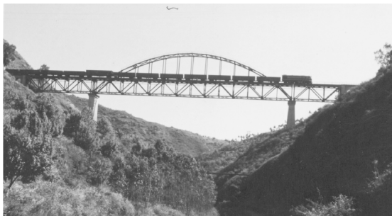
图 3 成昆铁路迎水村大桥
