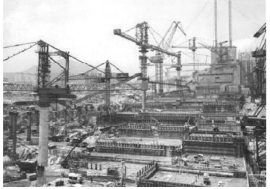
图 2 三峡混凝土施工场面
