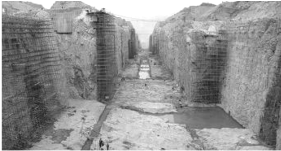
图 1 三峡船闸高边坡开挖及支护
