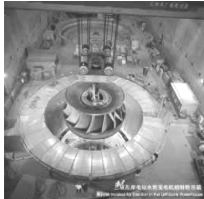
图 3 三峡左岸机组转轮吊装
