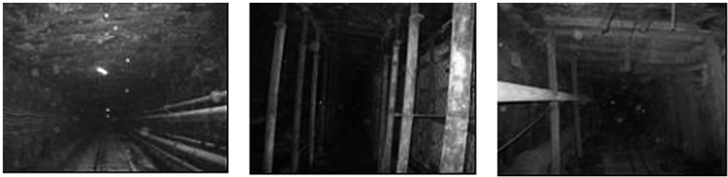
图8 顾桥煤矿 1115(1) 沿空留巷采用新型三高锚杆的实际支护状况
