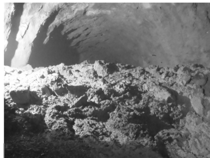
图10 掌子面揭示溶洞
