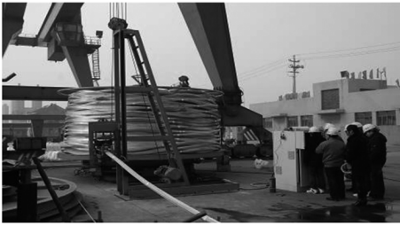
图 8 超长高强度索股智能放索试验 Fig. 8 Intelligent cable releasing test
