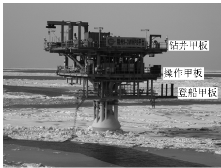
图2 JZ9-3WHPB 平台实景照片 Fig. 2 Photo of JZ9-3WHPB platform
