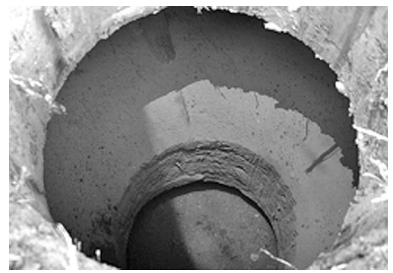
图 3 旋转挤扩所成的盘腔
