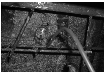
图8 现场渗压计布置图
