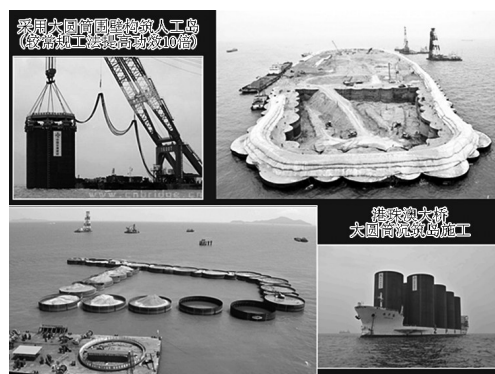
图7 港珠澳大桥大圆筒震沉筑岛施工
