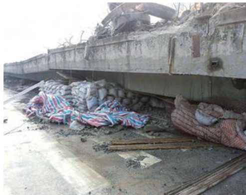
图14 沌阳高架桥爆破效果
