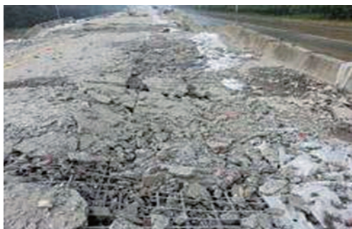
图6 多室箱梁水压爆破破碎形态
