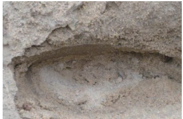
图6 固砂剂边坡入渗、固化情况
