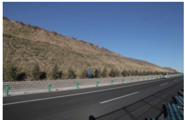
图7 两年后砂质边坡的固化效果
