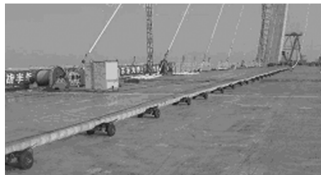
图 2 苏通大桥斜拉索桥面展开后的形状 Fig. 2 Outspreading cables of Sutong Bridge
