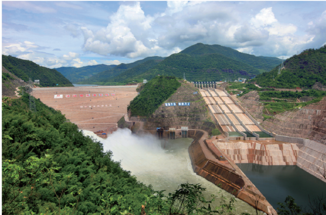
图17. 建成投运的糯扎渡水电站。
