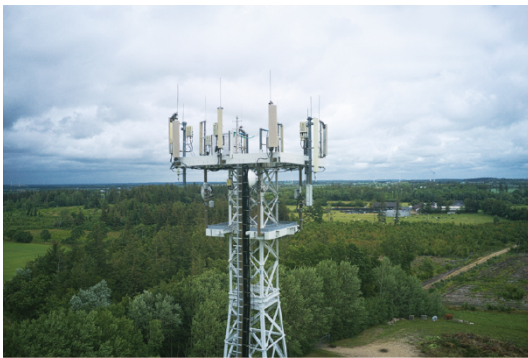
图 1. 此类 5G 发射塔的传输频率与航空高度表的工作频率相近。使用该传输频率能提高用户的手机性能, 但也可能会干扰某些高度表的正常工作。来源: Fabian Horst (CC BY-SA 4.0)。
