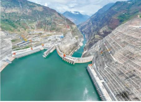
图2. 白鹤滩大坝于2022年6月通过了72 h 试验，其16台混流式水轮机中的一半已开始正式投产，每台水轮机的机组功率1 GW。当这16台全球最大的涡轮机于2022年年底均投入运行时，这座大坝预计将成为全球第二大水力发电站。来源：长江三峡集团（公有领域）。
