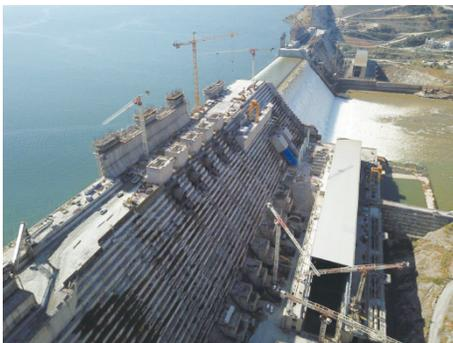
图1. 施工中的埃塞俄比亚复兴大坝。大坝由Webuild集团（意大利米兰）从埃塞俄比亚电力局承建，接近完工。如图所示，水流通过非常溢洪道倾泻而下，大坝的两个发电站设置在两侧灰色长方体处。来源：Webuild集团（公有领域）。
