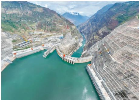
**图2.**白鹤滩大坝于2022年6月通过了72 h试验，其16台混流式水轮机中的一半已开始正式投产，每台水轮机的机组功率1 GW。当这16台全球最大的涡轮机于2022年年底均投入运行时，这座大坝预计将成全球第二大水电站。来源：长江三峡集团（公有领域）。
