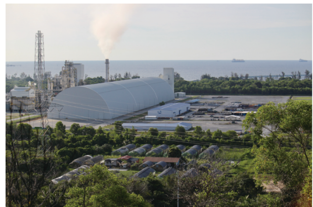
图 2. 与世界上几乎所有其他氨工厂一样，文莱的这家氨工厂采用哈伯-博世（Haber-Bosch）工艺，通过燃烧化石燃料生产氨。该工厂于 2022 年开工，日产氨量为 2200 t。图片来源：DeltaSquad833, Wikimedia Commons（CC BY-SA 4.0）。
