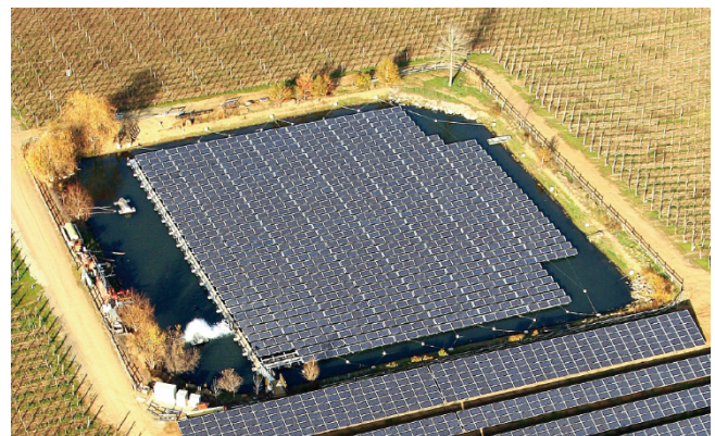
图2. 一座覆盖于美国加州纳帕谷的Far Niente酒厂内一个水池上的小规模漂浮光伏系统。该系统包含近1000块电池板，与一旁陆地上的电池板一起可产生高达400 kW 的电力，足以满足酒厂的电力需求。来源：SPG太阳能（CC BY-SA 3.0）。
