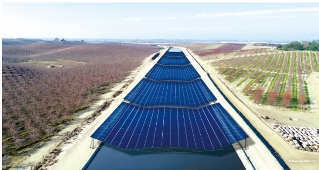
图1. 加州中央谷地的一运河顶太阳能电池阵列在2024年完成后的样子（艺术家构想图）。该部分采用桁架设计横跨运河，宽约33 m。来源：Nexus项目（公共领域）
