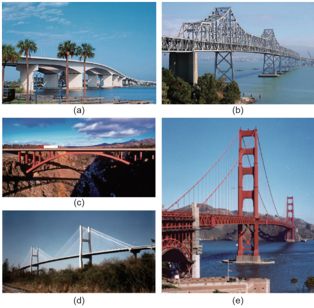
图3. 桥梁类型。(a) 阿科斯塔桥 (梁桥); (b) 旧金山-奥克兰海湾大桥 (桁架桥); (c) Crooked River Bridge (拱桥); (d) Talmadge 纪念桥 (斜拉桥); (e) 金门大桥 (悬索桥)。
