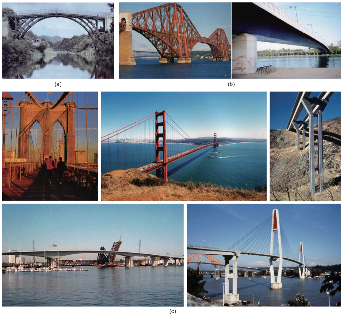
图2. 钢铁的引入促进了新的桥梁形式的发展。(a) 铁没有改变桥梁形式（普里查德的煤溪谷铁桥）；(b) 高强度钢丝促进了新的桥梁类型的产生；(c) 应用高强度钢丝后，桥梁工程开启了全新的篇章。
