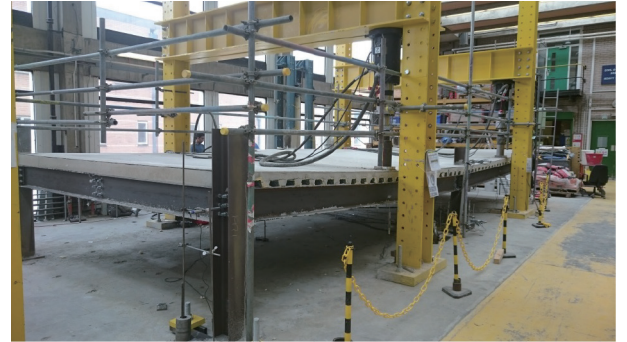
图22. 由于移除了中心柱的支撑件，边梁出现变形。
