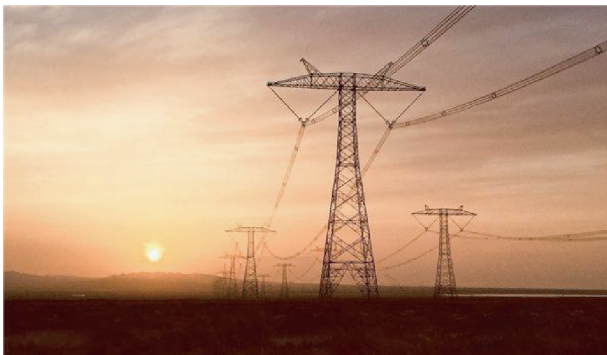
图1. 过去20年，中国积极扩大了高压输电能力。图为新建运行的1100 kV的超高压直流输电线路的一部分。该线路是输送距离最长、电压最高的线路，连接中国西北部的新疆和东部的安徽，全长3293 km。图片来源：人民网湖北频道，2019年9月28日。
