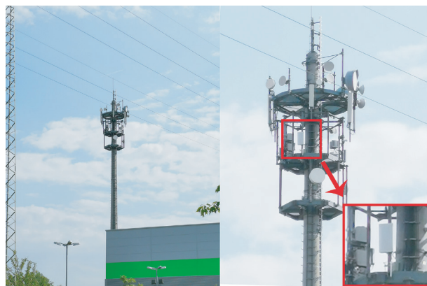
图3. 向5G网络的过渡已经开始。截至2020年2月，至少有34个国家的城市已经部署了一些5G计划[4]，如图中显示的2019年8月在德国卡尔斯鲁厄的一个基站进行的5G升级（3.5 GHz, n78频段）。图片来源：Tomas Freres, Wikimedia Commons (CC BY-SA 4.0)。
