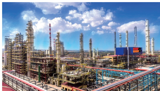
图3. 宁夏宝丰二期CTO工厂，于2018年开工。采用新型DMTO催化剂，使该装置生产每吨低碳烯烃对应的甲醇消耗量降至2.85 t。
