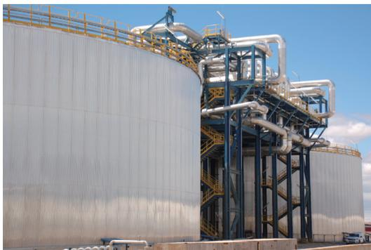
图3. 西班牙50 MW Andasol 3号CSP电站中的双罐熔盐储热系统, 储存约28 500 t太阳盐, 储存热量最多可供电站满负荷发电约7.5 h (图片来源: Andasol 3 CSP电站)。
