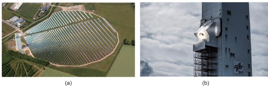
图8. DLR的CSP中试装置[66–68]。(a) Juelich Solar Tower; (b) 测试中的颗粒接收器CentRec。
