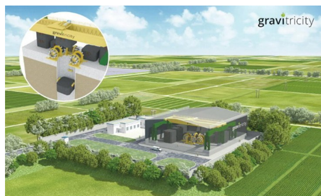
图5. Gravitricity公司的重力储能系统，利用现存矿井或专门竖井修建。在竖井内抬升重约1000 t的单个重物以储能，或下降以释放能量。来源：Gravitricity（已授权）。
