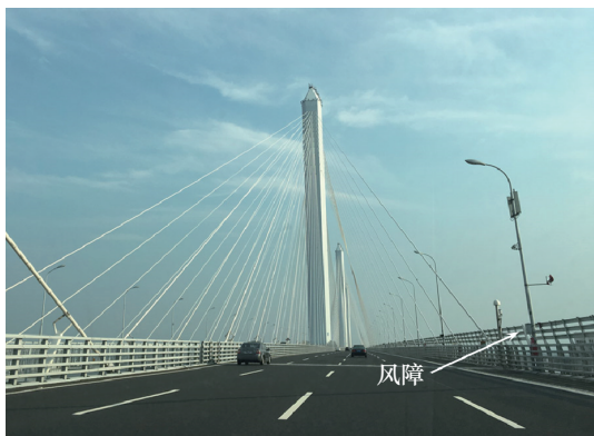
图 5 嘉绍大桥风障
