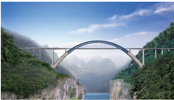
图7. 成贵铁路鸭池河大桥。
