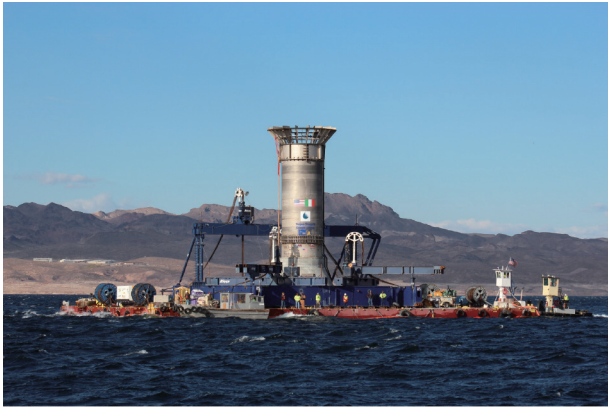
图8. 取水建筑物下放就位。
