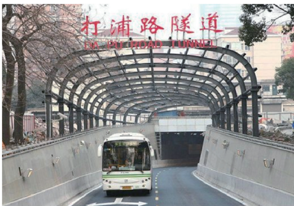
图1. 上海打浦路隧道。
