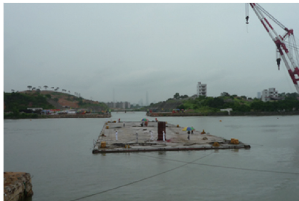
图2. 岸控式管节浮运。
