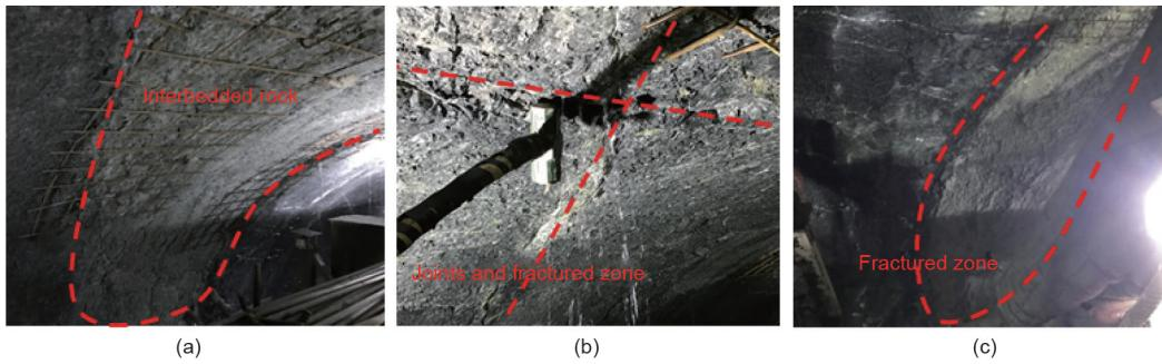
图7. TBM开挖揭露图。(a) 岩性交界面; (b)揭露裂隙; (c) 软弱围岩。
