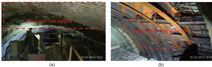
图10. TBM开挖揭露图。(a) 破碎围岩照片；(b) 破碎围岩大面积线状流水照片。
