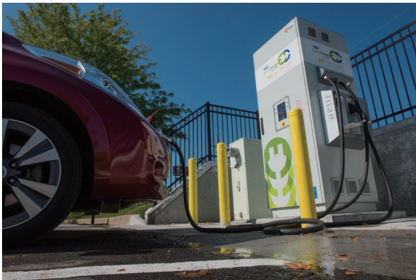
图1. 美国中部密苏里州堪萨斯城的直流（DC）快速充电站为EV电池充电。DC快速充电站能提供更高功率的电力，因此比其他大多数充电站充电更快。根据2019年1月的EV行业分析，在美国人口最多的50个大都市区中，堪萨斯城脱颖而出，成为唯一一个在2017年年底其充电站数量就可以满足2025年EV预期数量的城市。图片来源：Energys授权发布。
