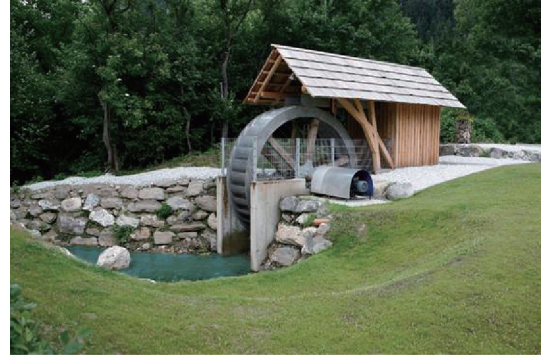
图3. 上射式水轮，直径为4 m，宽0.75 m。
