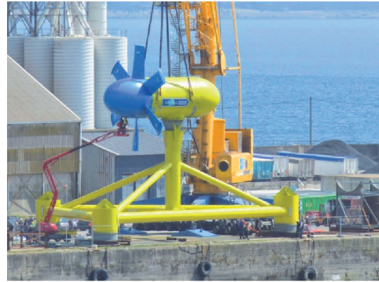
图6. 位于布雷斯顿的Sabella D10潮汐涡轮机码头，安装前的照片由Erwann Nicolas（Sabella，法国）提供。
