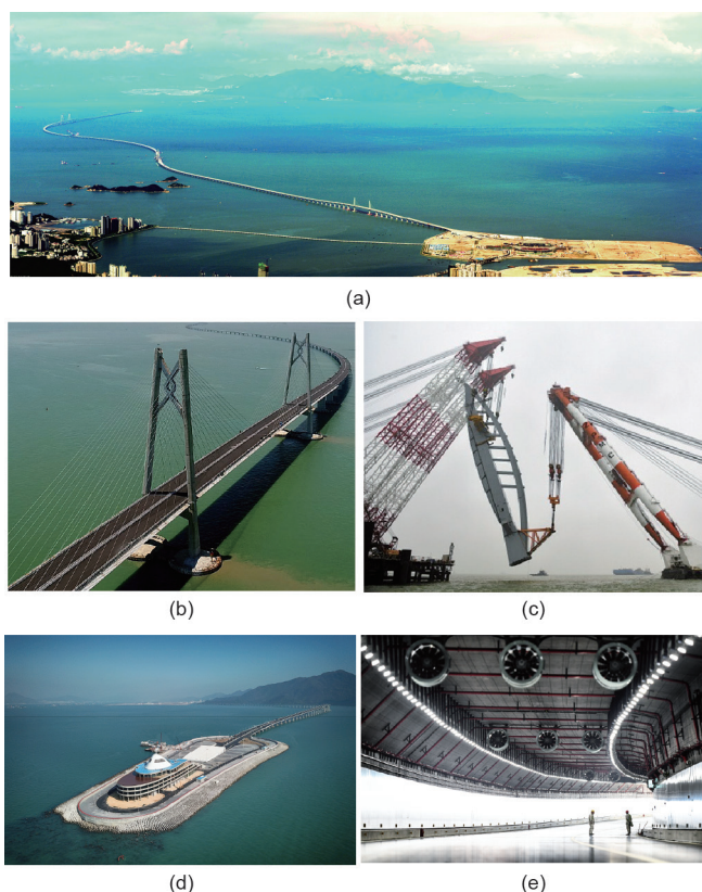
图2. 港珠澳大桥主体段桥梁。(a) 远眺桥梁；(b) 青州航道桥中国结；(c) 江海桥海豚塔安装；(d) 东人工岛连接桥梁与隧道；(e) 隧道内视。
