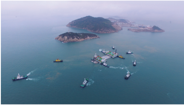
图7. 最后一个安装的管节E30。
