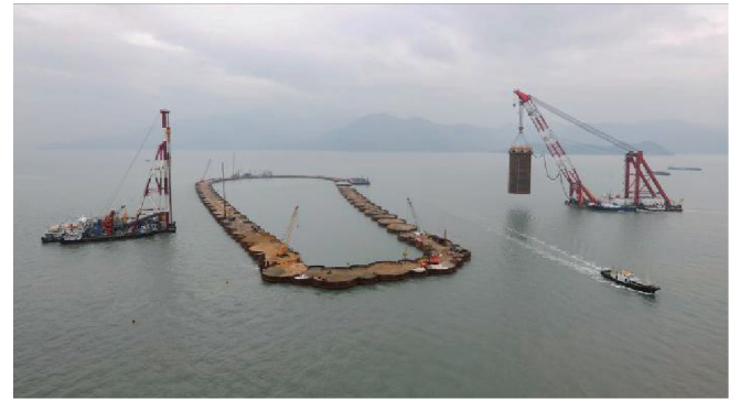
图3. 东人工岛最后一个钢圆筒的打设。
