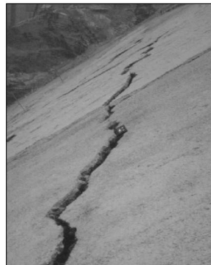
图6 天生桥一级垫层料裂缝情况
