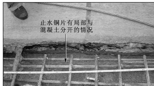
图7 天生桥面板沿垂直缝L3/L4崩角压损
