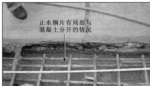
图 7 天生桥面板沿垂直缝 L3/L4 崩角压损
