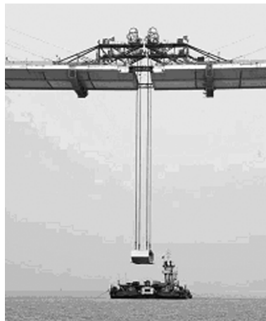
图 4 中跨合龙梁段吊装
