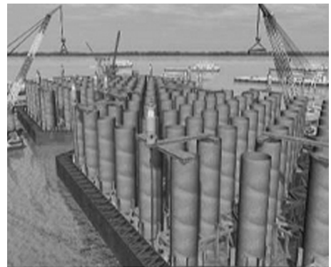
图4 南主墩钢吊箱整体沉放示意图
