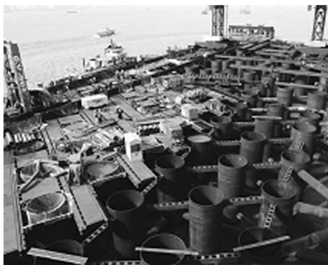
图2 北、南主塔墩基础施工平台搭设方案
