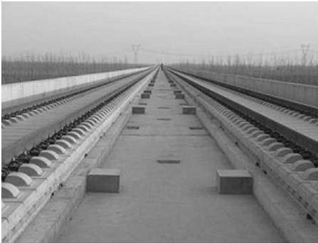
图4 施工中的桥上无砟轨道照片
