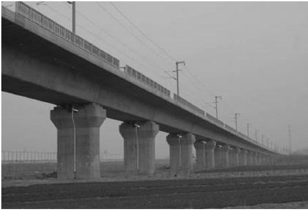
图6 杨村特大桥双线圆端形筒支梁照片
