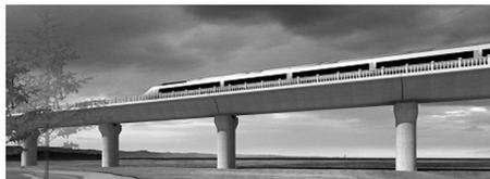
图5 双线圆端形桥墩简支梁桥式效果图
