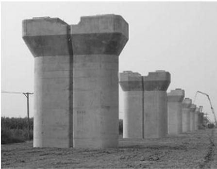
图7 施工中的双线圆端形桥墩
