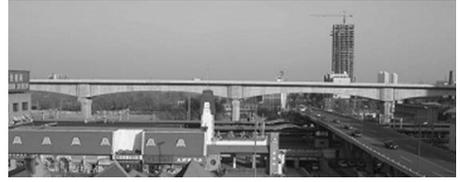
图8 常用跨度(45 + 70 + 70 + 45) m连续梁照片
