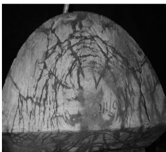
图6 试样表面裂缝图
