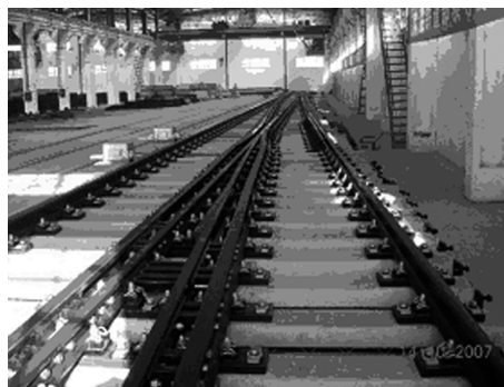
图 8 350 km/h 18 号无砟道岔厂内组装
