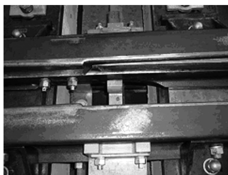
图 6 水平藏尖式心轨结构
