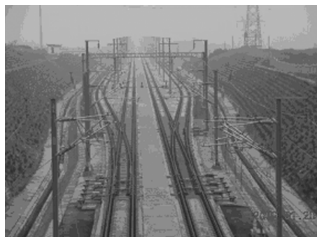
图19 铺设于武广客运专线的 350 km/h 18号无砟道岔
