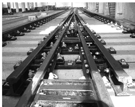
图 7 18 号道岔翼轨跟端结构
